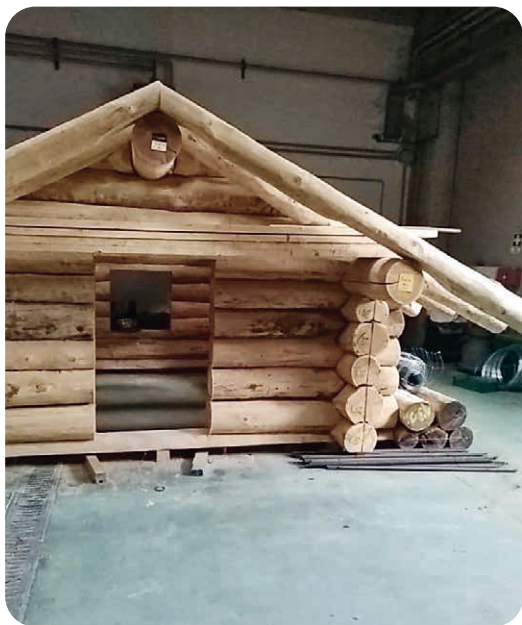
Foto A - Modulo blockbau pre-assemblato a Borgo Valsugana, in previsione della posa in opera in quota (UDF Borgo - Archivio Servizio Faunistico PAT)
